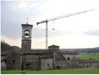
Il complesso di Astino
